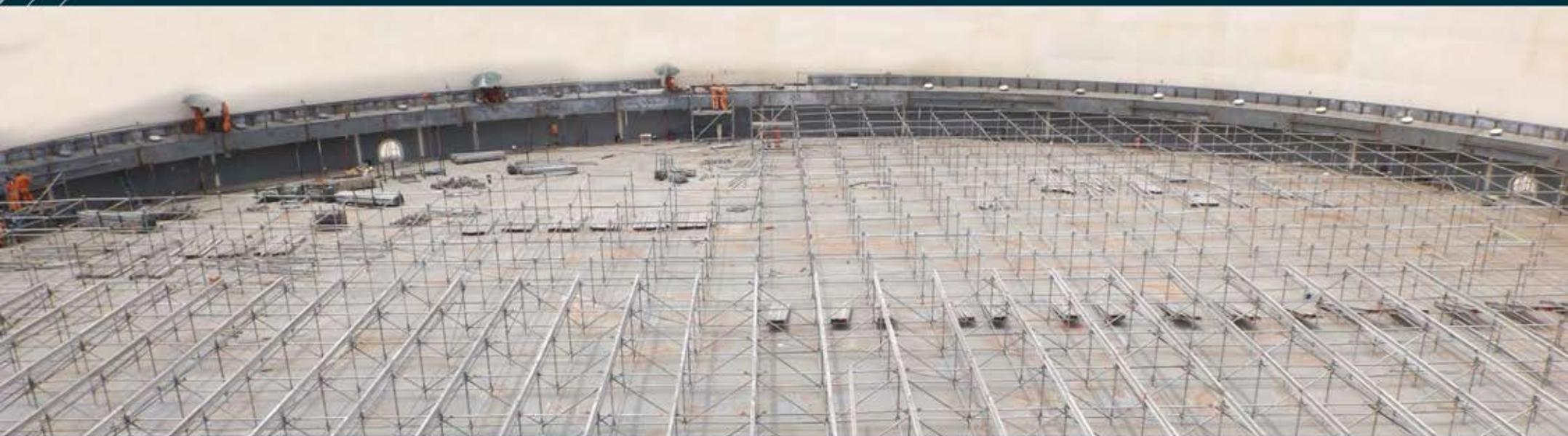
**FABRICACIÓN Y MONTAJE DE CÚPULA FLOTANTE PARA TANQUE DE 500,000 BARRILES**
