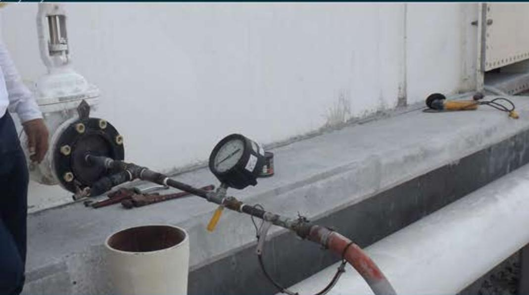
**PRUEBAS HIDROSTÁTICAS | Sistemas de tubería**
